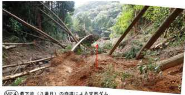
(M24) 最下流（3番目）の前堰による天然ダム
