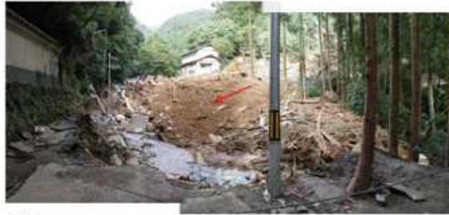
(M30) 現道の流失後土石流により河川埋没
