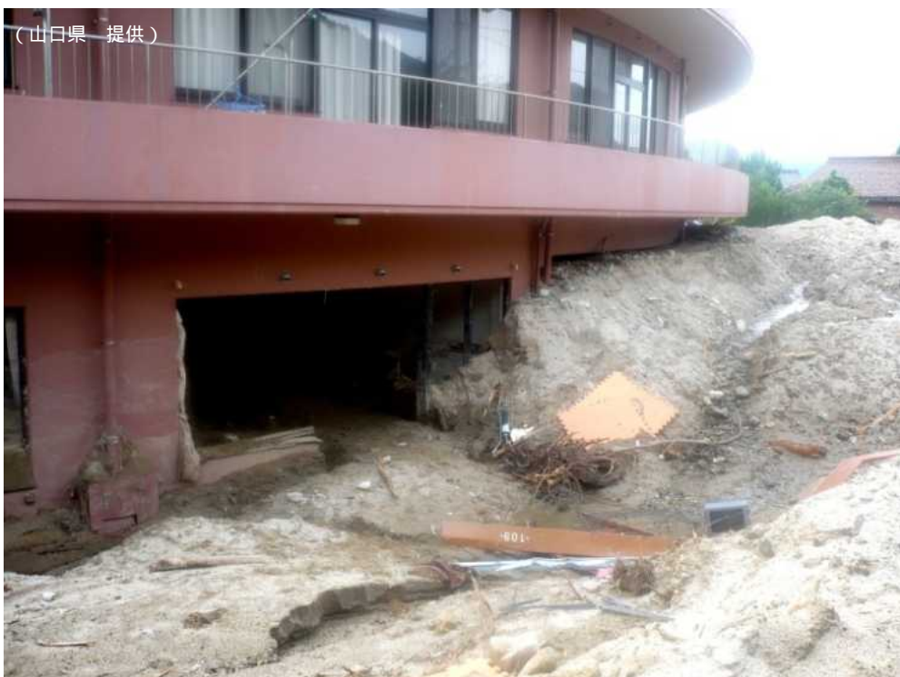
土石流の被害を受けた災害時要援護者関連施設 (平成 21 年 7 月 21 日、山口県防府市、死者 7 名)
