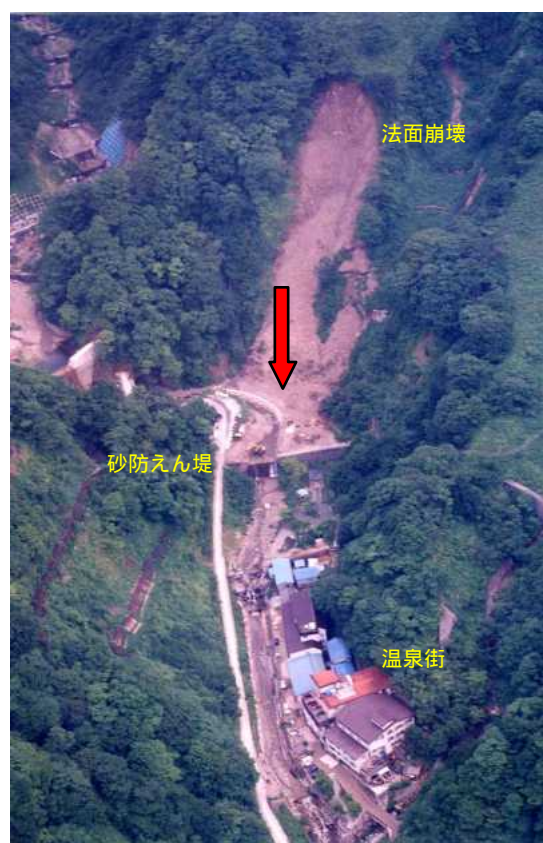
下流の温泉街を護った砂防えん堤(石川県白山市) (土砂災害を防ぐ 砂防施設効果事例集2005 より)
