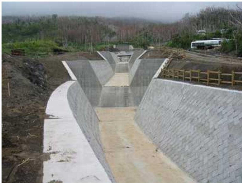
金曾沢(長さ645.3m) 流路(平成17年度完成)
