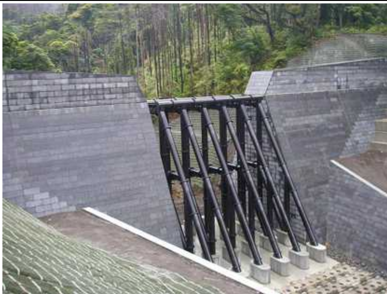
釜の尻沢(高さ14.5m 長さ61.9m) コンクリートダム(平成17年度完成)
