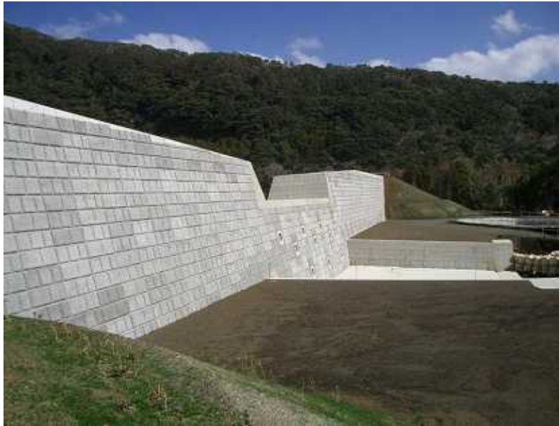
道の沢(高さ8.5m 長さ510.0m) ソイルセメントダム(平成18年度完成)
