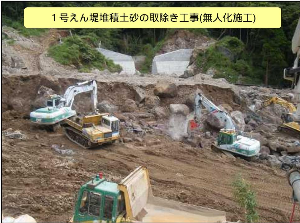
1号えん堤堆積土砂の取除き工事(無人化施工)
