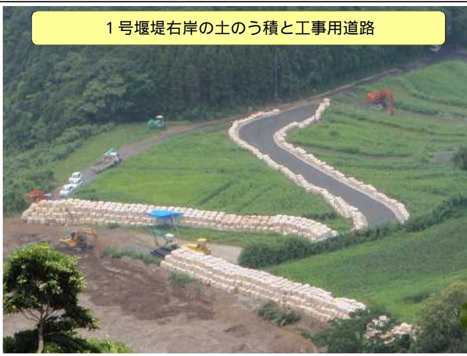
1号堰堤右岸の土のう積と工事用道路
