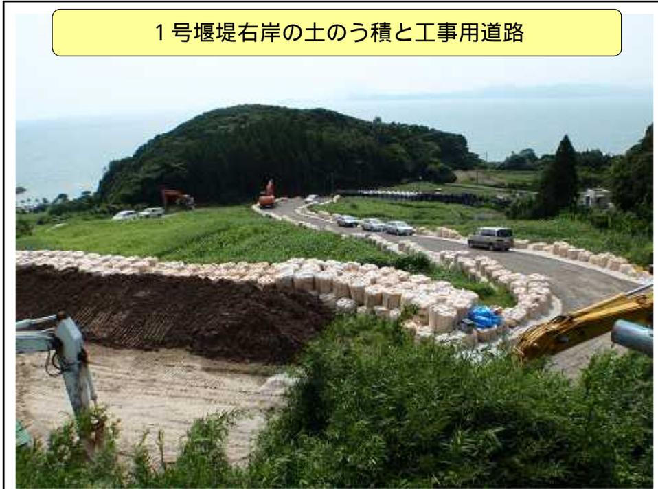
1号堰堤右岸の土のう積と工事用道路
