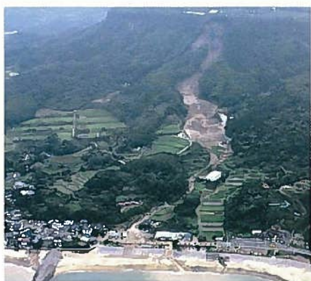
鹿児島県南大隅町の災害 (撮影：九州地方整備局)
