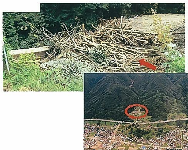
砂防堰堤における土石流捕捉状況 (長野県諏訪市小田井沢川)
