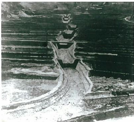
雲原山谷川完成当時（京都府福知山市） （「砂防と治水172号」より（京都府砂防課））
