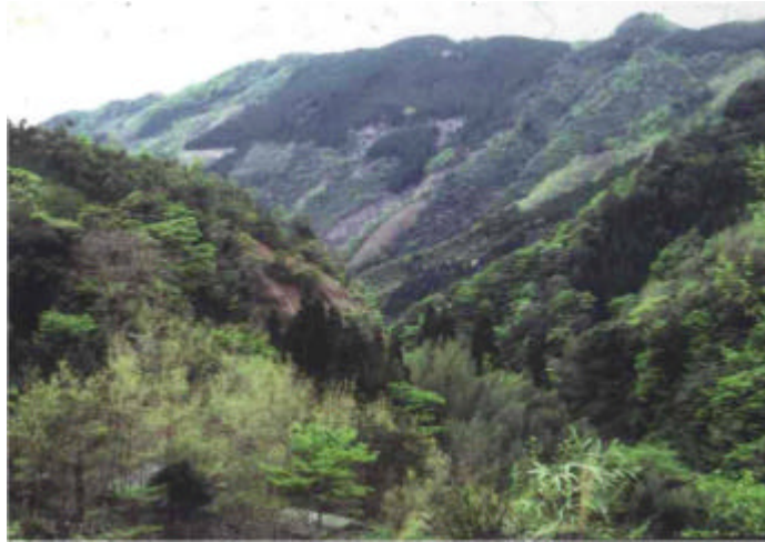
斜面の変状 (開口亀裂の発生) (宮崎県椎葉)
