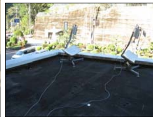
▲ku-sat(衛星アンテナ)の設置
