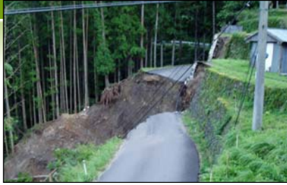
▲崩れ落ちた村道と共に切断した電線類(谷垣内地内)
