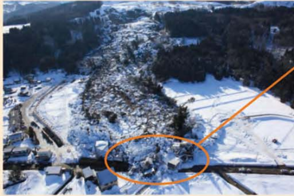
地すべり全景（3月14日撮影） 新潟県上越市板倉区国川地区 人家破損4戸
