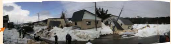
人家の被害状況
