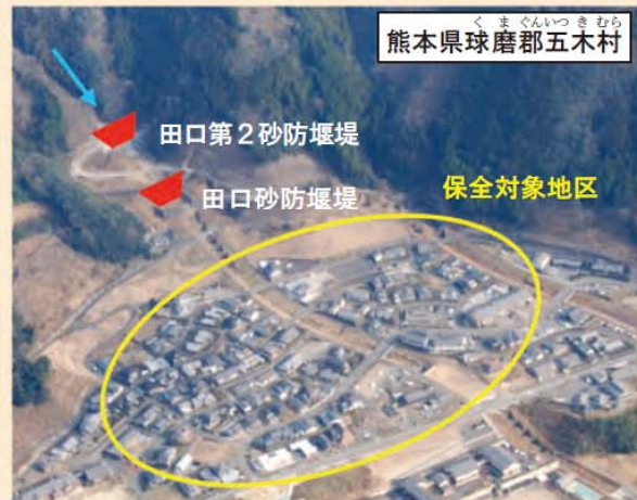
7月12日の降雨により、合わせて約7,000m 3 の土砂を捕捉
