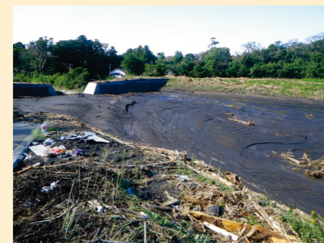
大金沢本川堆積工
