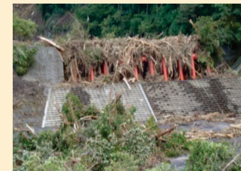
八重沢堆積工
