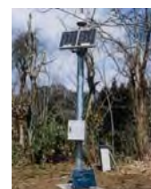
GPSを活用した地すべり監視
