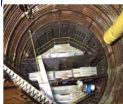
地すべりの動きを直接止めるための深礎杭施工
