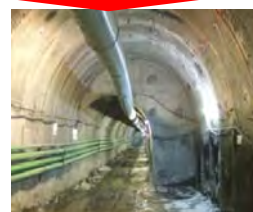
地下水排除のための排水トンネルの設置
