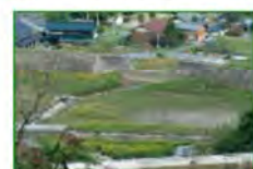
運れた土・すな・石をためる運砂地
