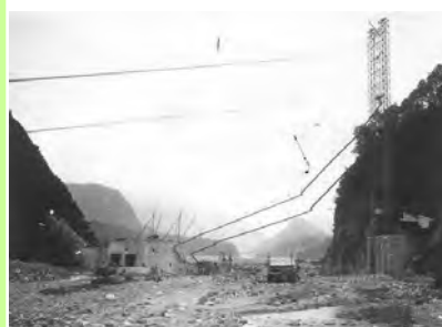
本宮砂防堰堤の施工状況 (1935年(昭和10年)～1937年(昭和12年))
