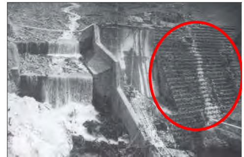
コンクリート方格柵
