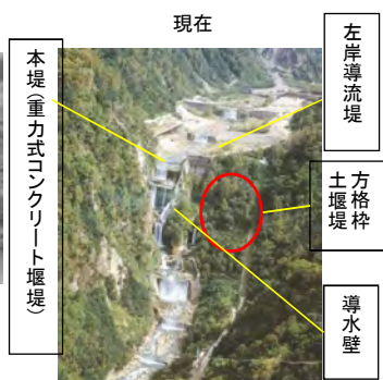
ハイブリッド構造の白岩堰堤 方格枠で植生回復
