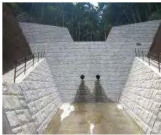
砂防ダムの諸元 大町7号砂防ダム H=9.0m, L=32.0m
