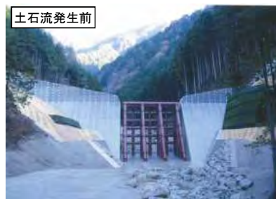
梨子沢第1砂防堰堤の状況
