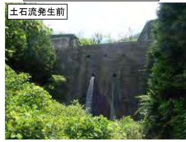
梨子沢砂防堰堤の状況
