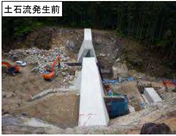
梨子沢第2砂防堰堤の状況
