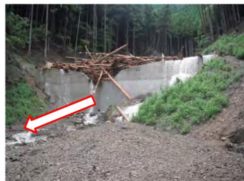
約2,000m<sup>3</sup>の土砂を捕捉
