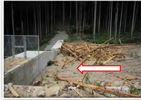
砂防えん堤が土砂・流木を抑止
