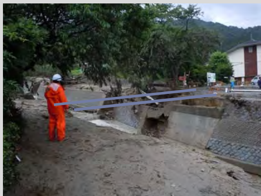
町道橋梁流失(青線)
