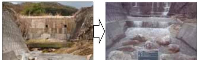
水叩工が洗掘を受け損傷
