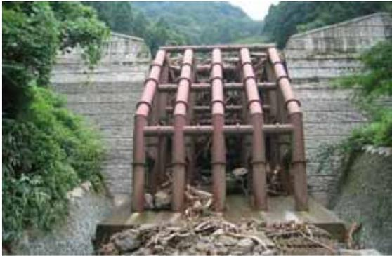
鋼製砂防堰堤
