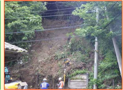
6/2 がけ崩れ よこすかし にしうらが 神奈川県横須賀市西浦賀5丁目
