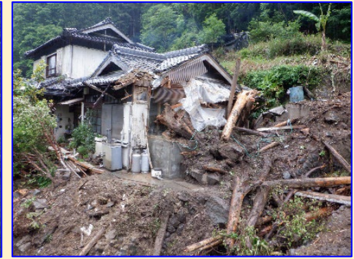
6/2 土石流等 ありだくん ありだがわちょうにさわ 和歌山県有田郡有田川町二澤
